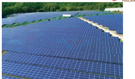
S-05 銚田太陽光発電所
