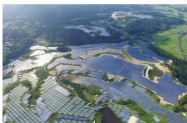
S-01 高萩太陽光発電所
