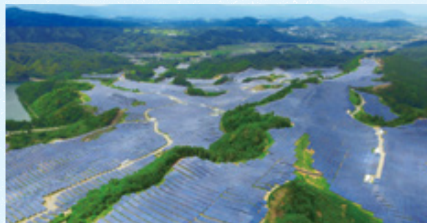
S-07 松阪太陽光発電所
