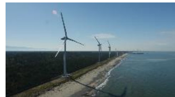
W-01 胎内風力発電所
