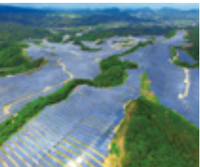
S-07 松阪太陽光発電所
