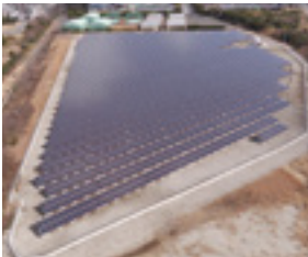
S-03 JEN防府太陽光発電所
