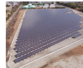
S-03 JEN防府太陽光発電所
