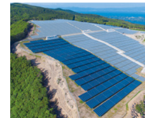
S-06 長崎琴海太陽光発電所
