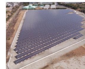
S-03 JEN防府太陽光発電所
