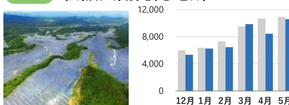
S-07 松阪太陽光発電所
