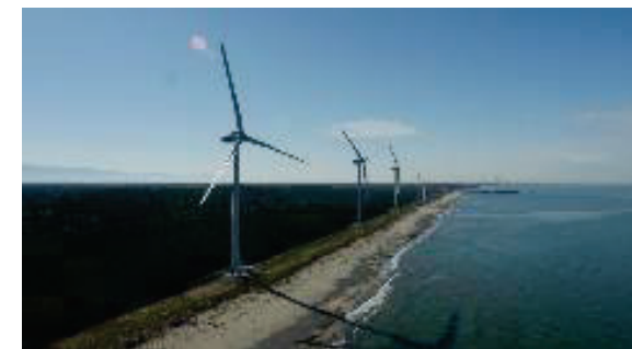
W-01 胎内風力発電所
