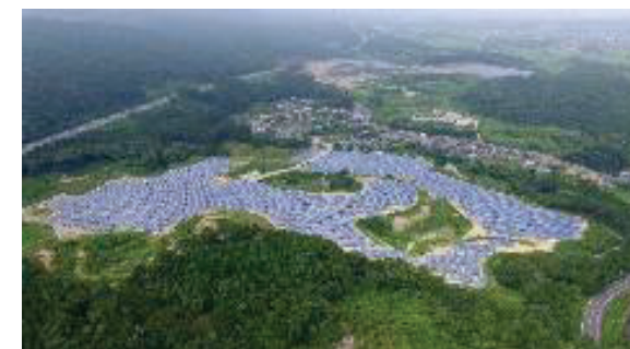
S-01 高萩太陽光発電所
