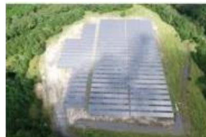
S-02 千代田高原太陽光発電所
