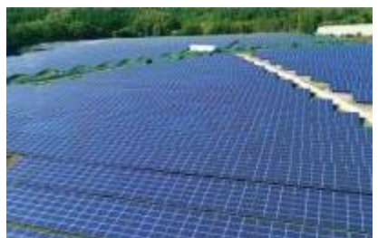
S-05 鉾田太陽光発電所
