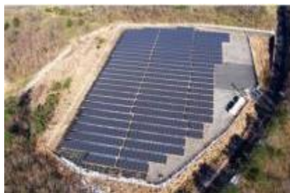
S-04 JEN玖珠太陽光発電所
